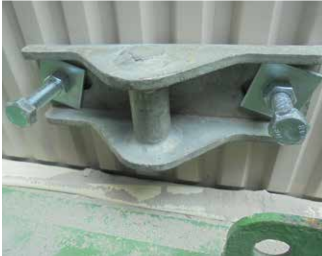
外壁養生台固定部
