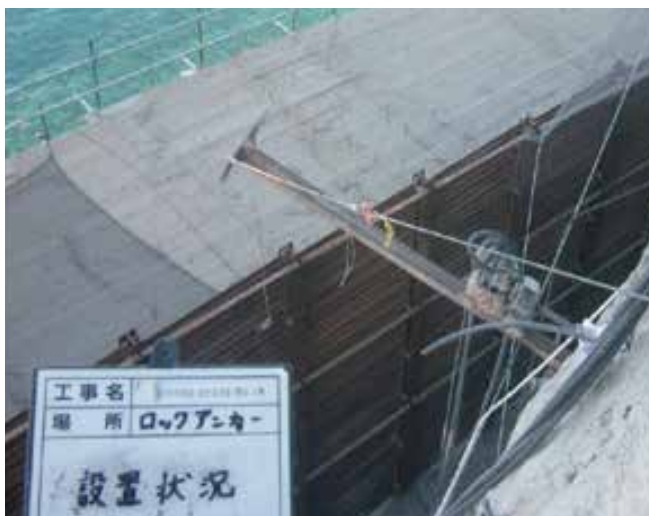
法面・斜面補強
