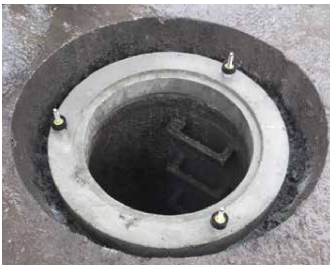
マンホール鉄蓋取替工事(円型取替工法での採用)
